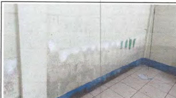
Foto 4: Pintura exteriores e interiores de edificio de 4 aulas de dos niveles.
