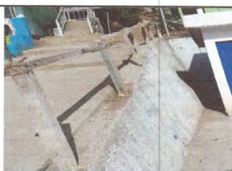
Foto 6: Aplicación de repello de muro de contención y sustitución de baranda de metal con tubo de proceso
