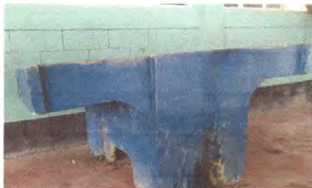
Foto 11: Sustitución de pila en cocina escolar
