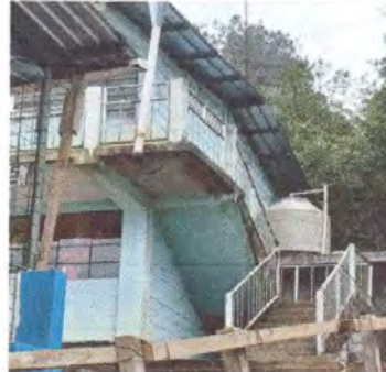
Foto 8: Reparación de bajada de agua pluvial tubo pbc
