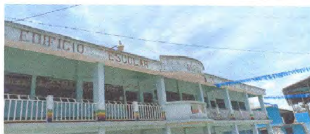
Foto 3: Pintura exteriores e interiores de edificio escolar de 6 aulas de dos niveles
