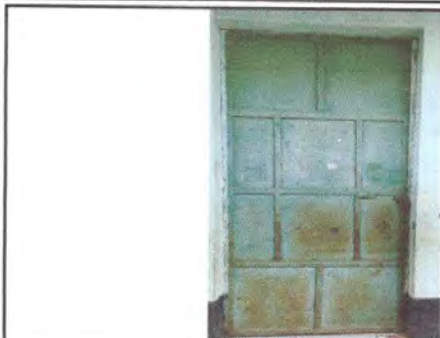
Foto 1: Mantenimiento a estructura: cepillado y aplicación de pintura a puertas de las aulas
