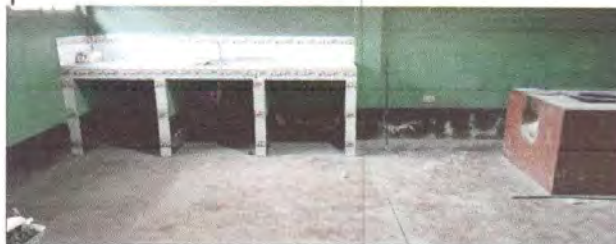
Foto 10: Sustitución de lavatrastos más accesorios. Sustitución de piso de concreto a piso de cerámico
