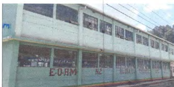
Foto 12.: Sustitución de vidrios
