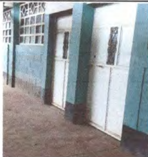
Foto 9: Pintura a paredes Exterior e interior cocina escolar y mantenimiento de estructura: cepillado y aplicación de pintura a puertas de cocina escolar. Mantenimiento a balcones de metal de cocina escolar
